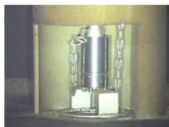
No.41 構造物状況(水位計)
