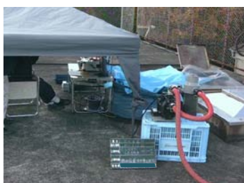
機材設置及び施工状況
