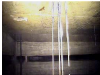
No.53 構造物状況 (天井部)
