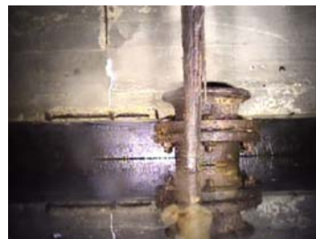
No.56 構造物状況 (天井部)
