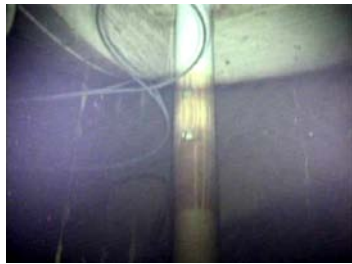
No.42 構造物状況(防波管)
