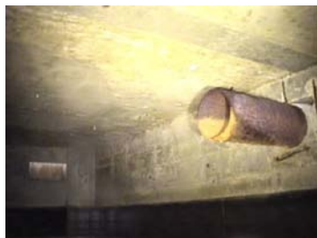
No.55 構造物状況 (天井部)
