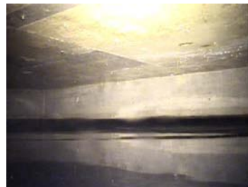
No.54 構造物状況 (天井部)
