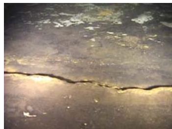
No.46 構造物状況(底部 陥没)
