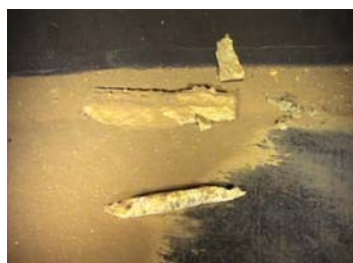
No.23 堆積状況 (コンクリート片)
