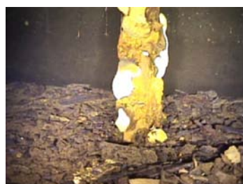
No.20 堆積状況 (鑄ガラ)
